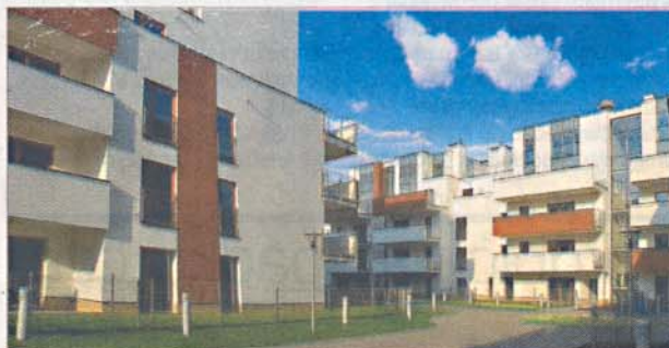
Bouygues Immobilier Polska w specjalnej cenie oferuje coraz to inne mieszkania, m.in. na osiedlu La Lumiere przy ul. Sarmackiej
